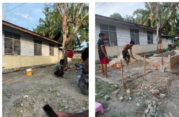
Gambar 1. Gotong Royong Membangun Kolam Ikan Sumber: Observasi Lapangan, 2025
