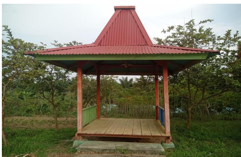
Gambar 6. Gazebo (panggung) Yang Sudah Tidak Terawat
